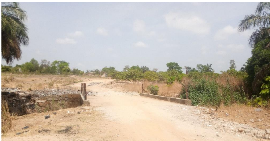
Figure 85 : Pont construit par les habitants de Salimdè se trouvant sur la route d'accès au site du Projet
