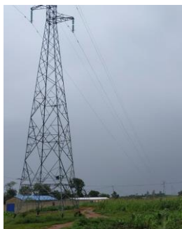
Figure 11 : Illustration d'un pylône de la ligne existante (ILF Consulting Group, 2020)
