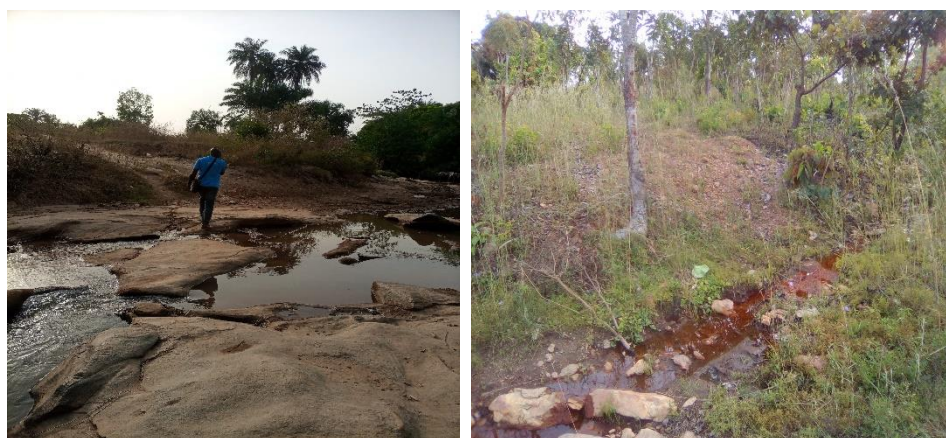
Figure 30: Illustrations de quelques écoulements d'eau dans la zone (JAT Consulting, 2024)
